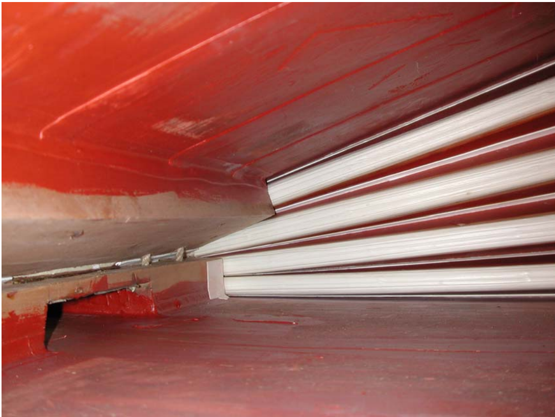
088 Balg von innen mit Ausblasöffnung
