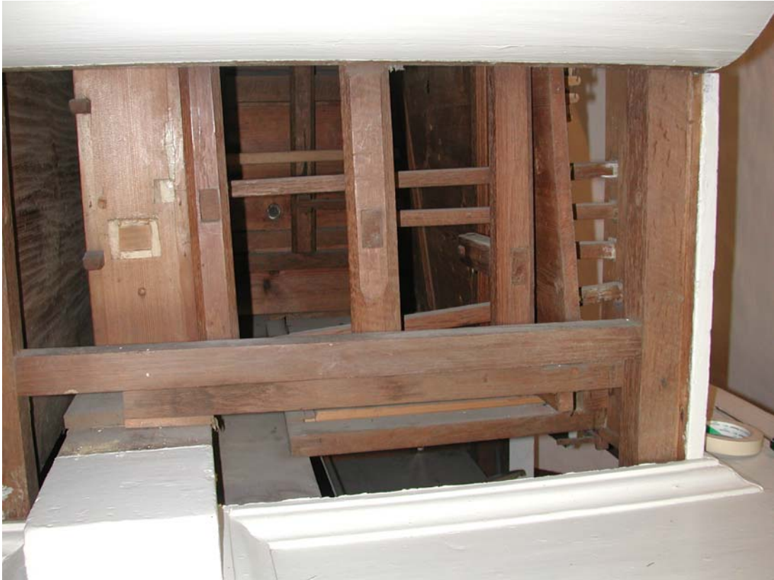
016 Kanalführung und Registermechanik rechts
