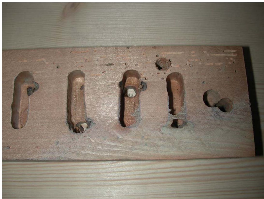
069/070 Mixturstock nach abhobeln der nichtoriginalen Decke
