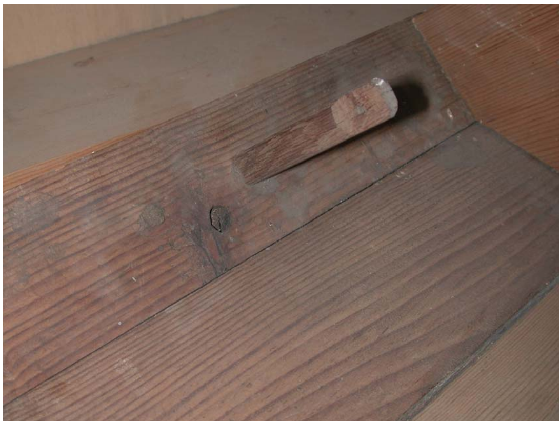
100 Ärmchen in linker Registerabdeckung
